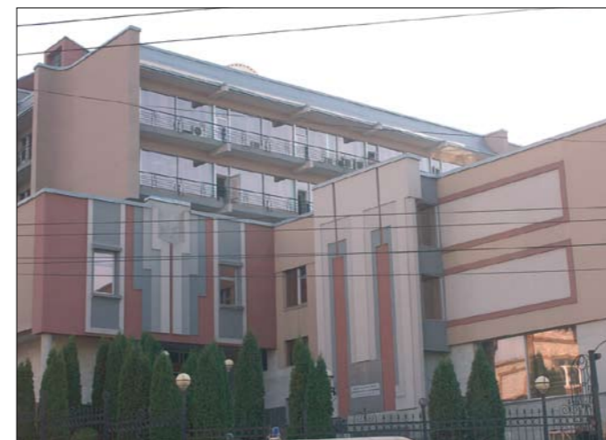
Вычислительный центр ЦБ
